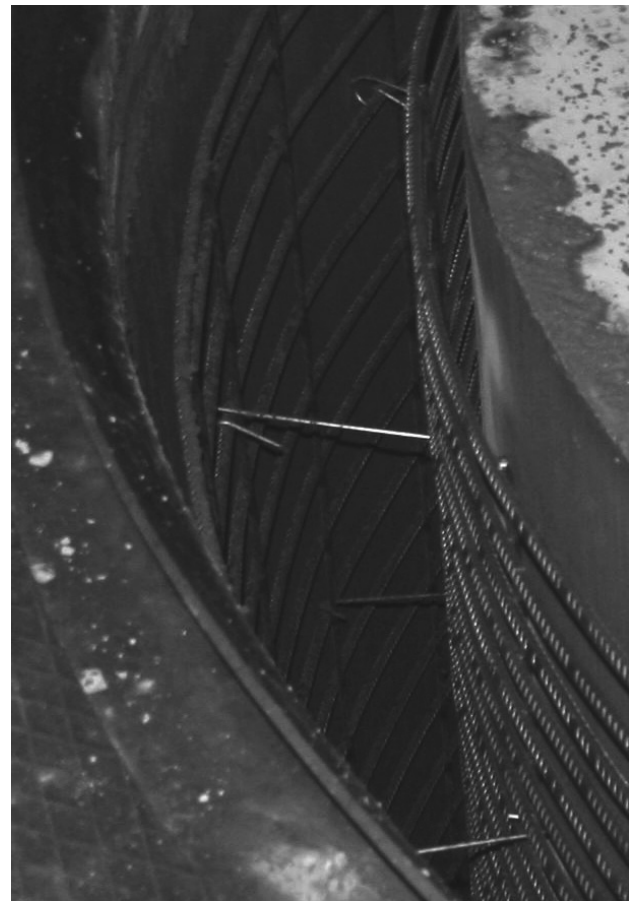
Figura 14. Estrategia empleada para garantizar la rigidez de las jaulas y los recubrimientos. Cortesía de PREFRAGA
